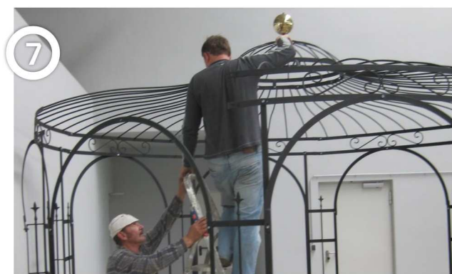
Kugel anbringen, bevor letzter Fächer angeschraubt wird.
