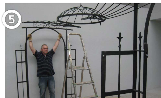
Eine dritte Person verbindet die Ständer-Fächerpaare mit der Kuppel.
