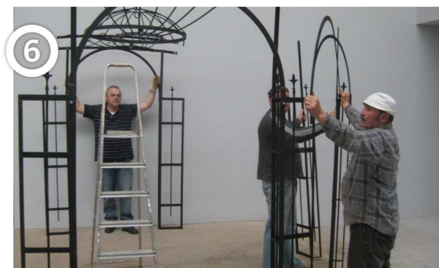
Drei Personen halten die Ständer, während eine vierte Person Ständer und Fächer fortlaufend anbringt.
